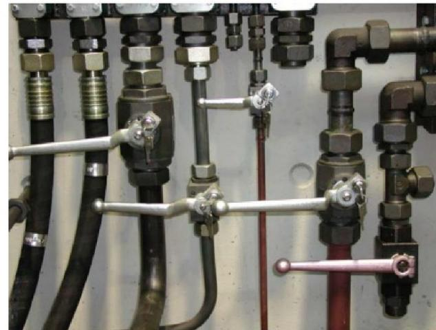
**Bild 3:** Sichern gegen Wiedereinschalten durch abschließbare Kugelhähne
